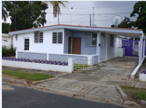
A-11,CALLE #3,REPARTO MARQUEZ ARECIBO 327.71 METROS CUADRADOS $78,300.00 OMO
